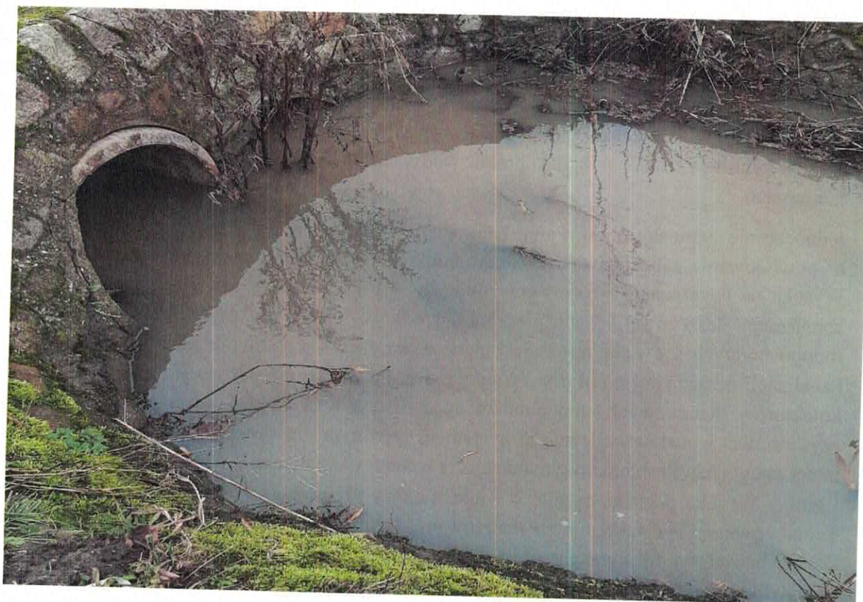
Zdjęcia wykonane w dniu 17.02.2022r. (wylot wód deszczowych ul. Św. Walentego w Wysokiej)
