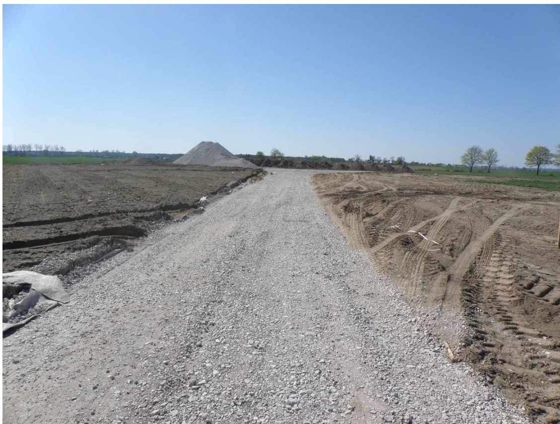
Ryc. 4. Przykładowy plac montażowy tymczasowy przy fundamencie turbiny wiatrowej.
